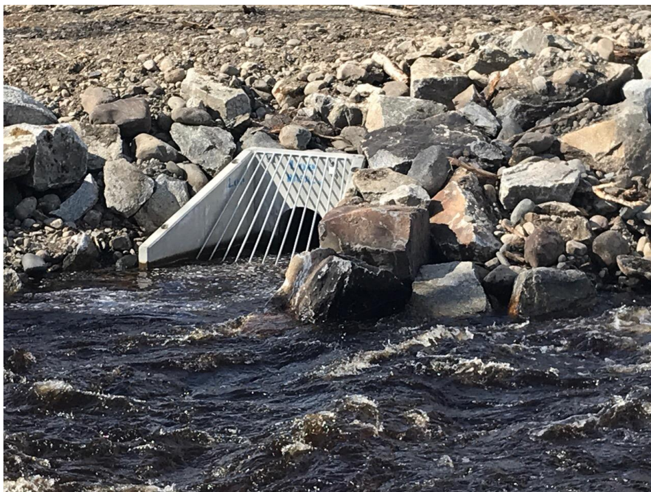
Figur 19: Rørintak på vestre flomverk, pel nr. 1600 (Bilde: Multiconsult).
