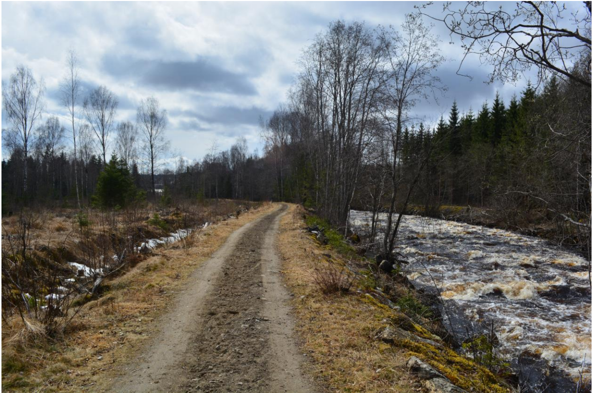
Figur 14: Oppstrøms ende av østre flomverk (Bilde: Multiconsult).
