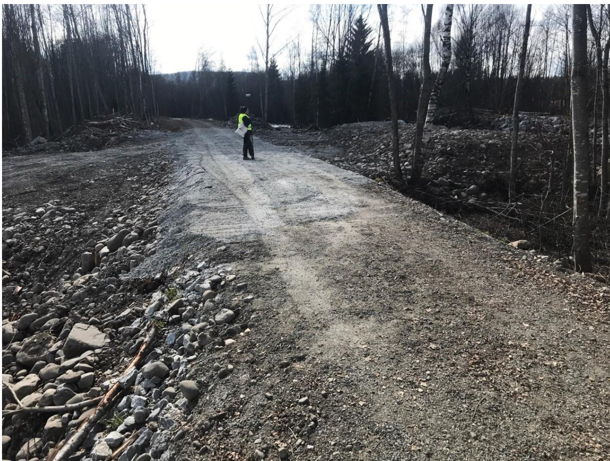
Figur 17: Nylig rehabilitert flomsikring ved pel nr. 1900 (Bilde: Multiconsult).
