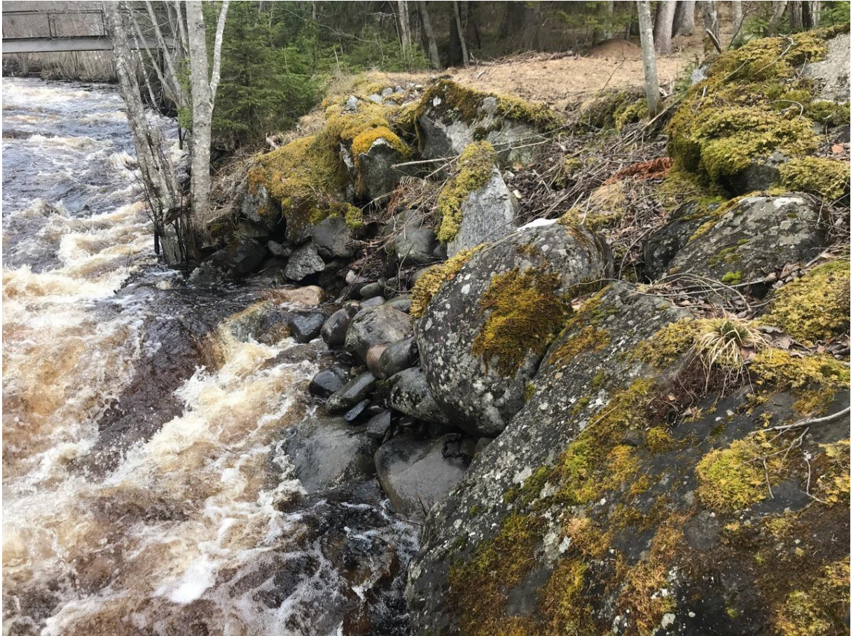
Figur 15: Skadet erosjonssikring og manglende steiner i oppstrøms ende av østre verk. (Bilde: Multiconsult)
