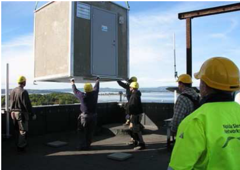
Montering av basestasjon på tak
