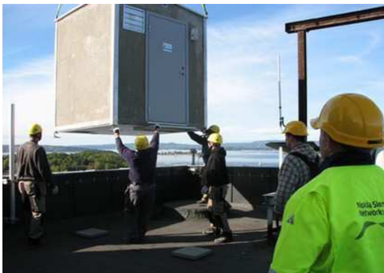
Montering av basestasjon på tak
